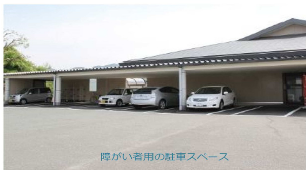
車いす対応駐車場
